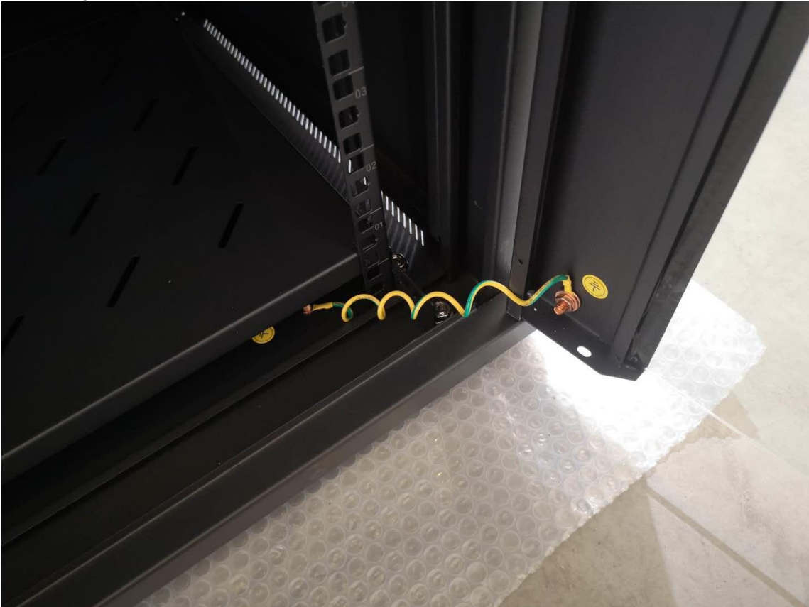
Instalación de toma de tierra de la puerta tal como mostramos en la imagen.
